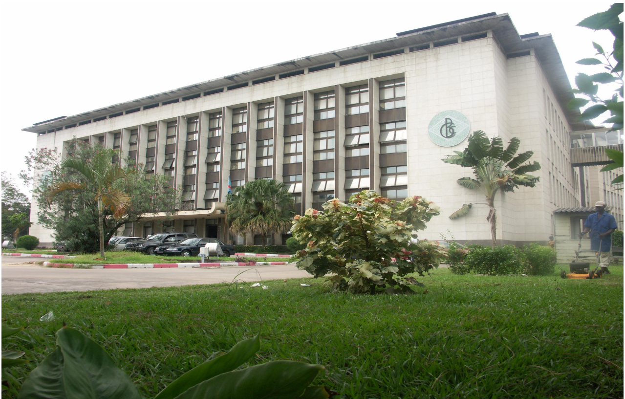
BANQUE CENTRALE DU CONGO, Siège de Kinshasa
