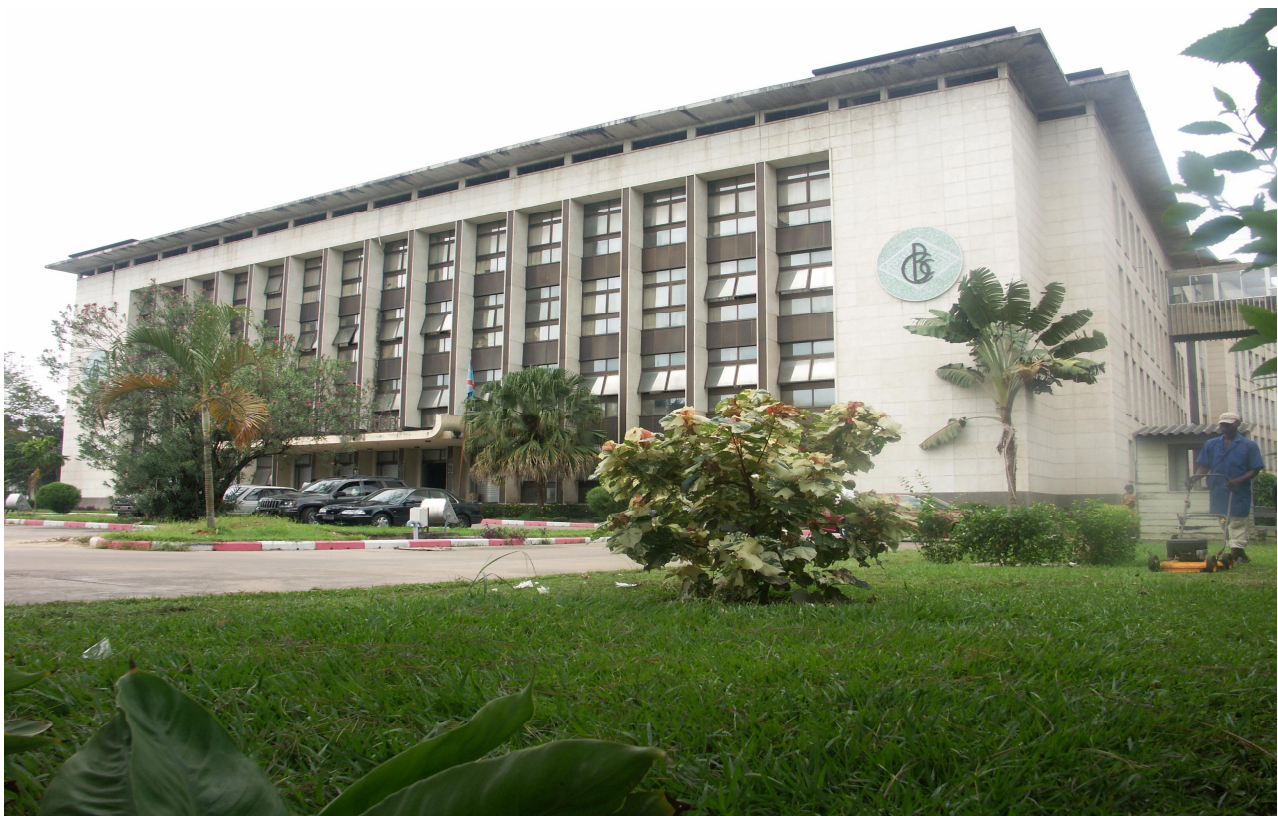
BANQUE CENTRALE DU CONGO, Siège de Kinshasa
