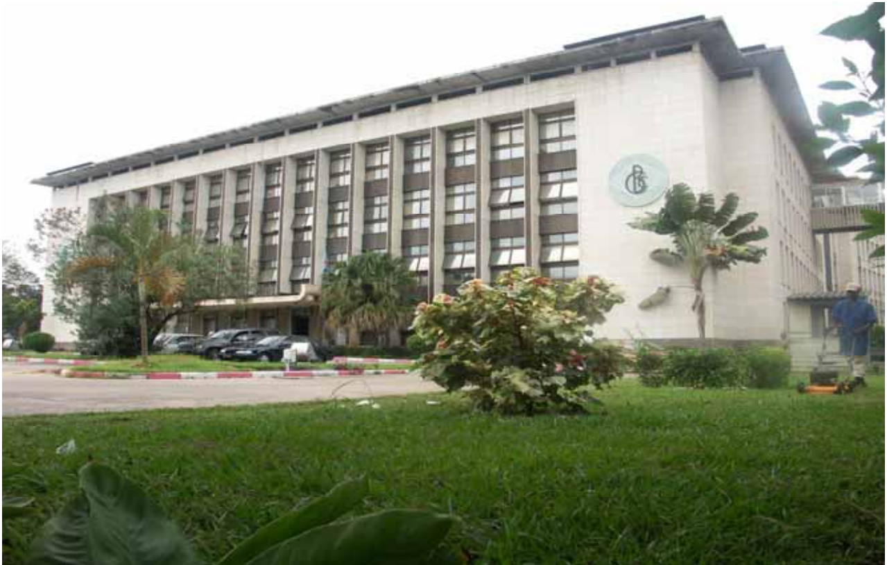
BANQUE CENTRALE DU CONGO, Siège de Kinshasa
