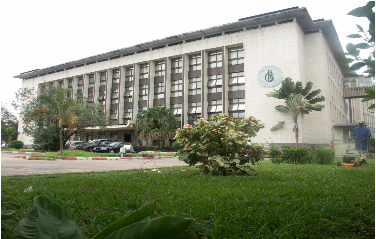
BANQUE CENTRALE DU CONGO, Siège de Kinshasa
