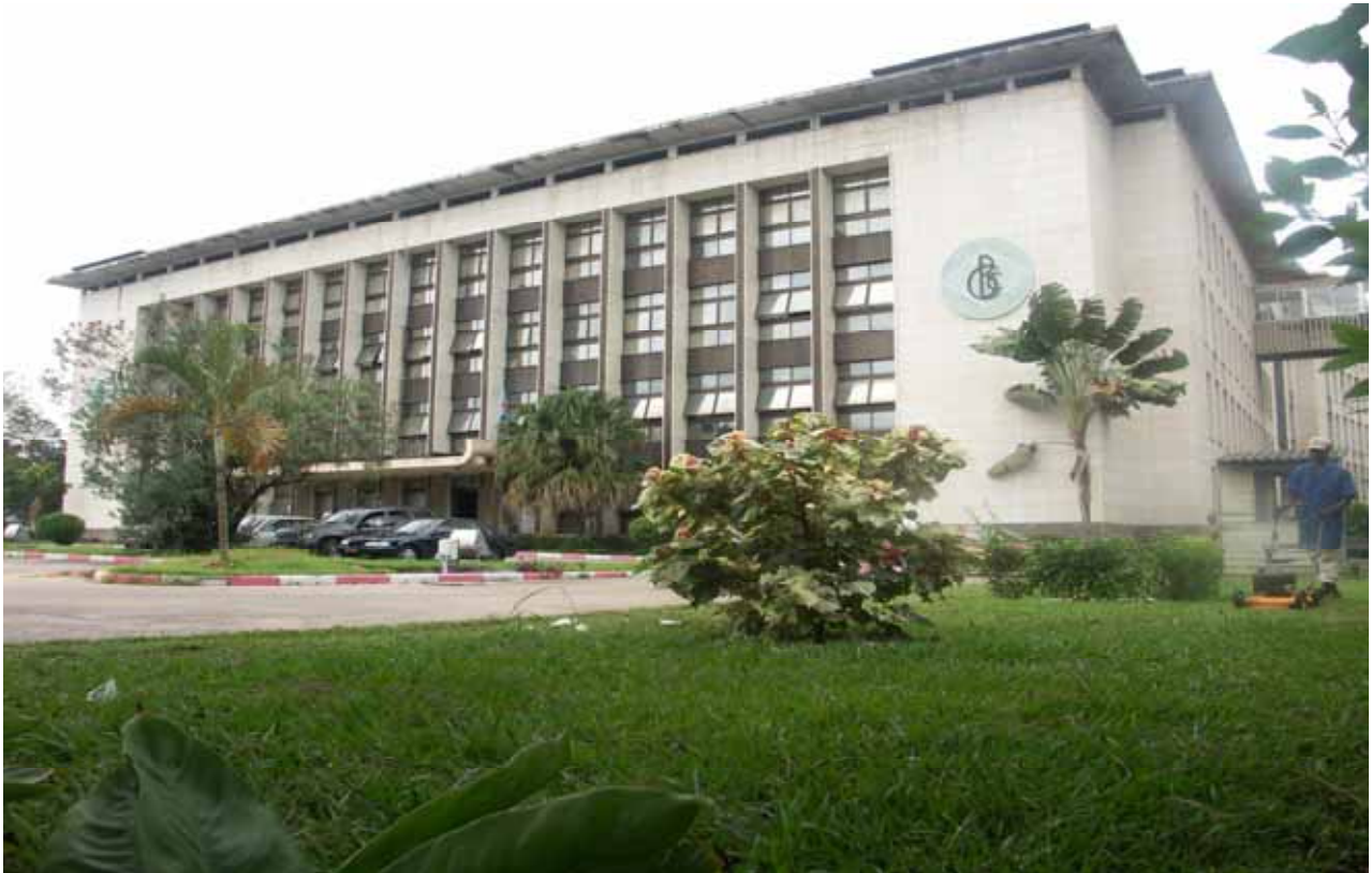
BANQUE CENTRALE DU CONGO, Siège de Kinshasa
