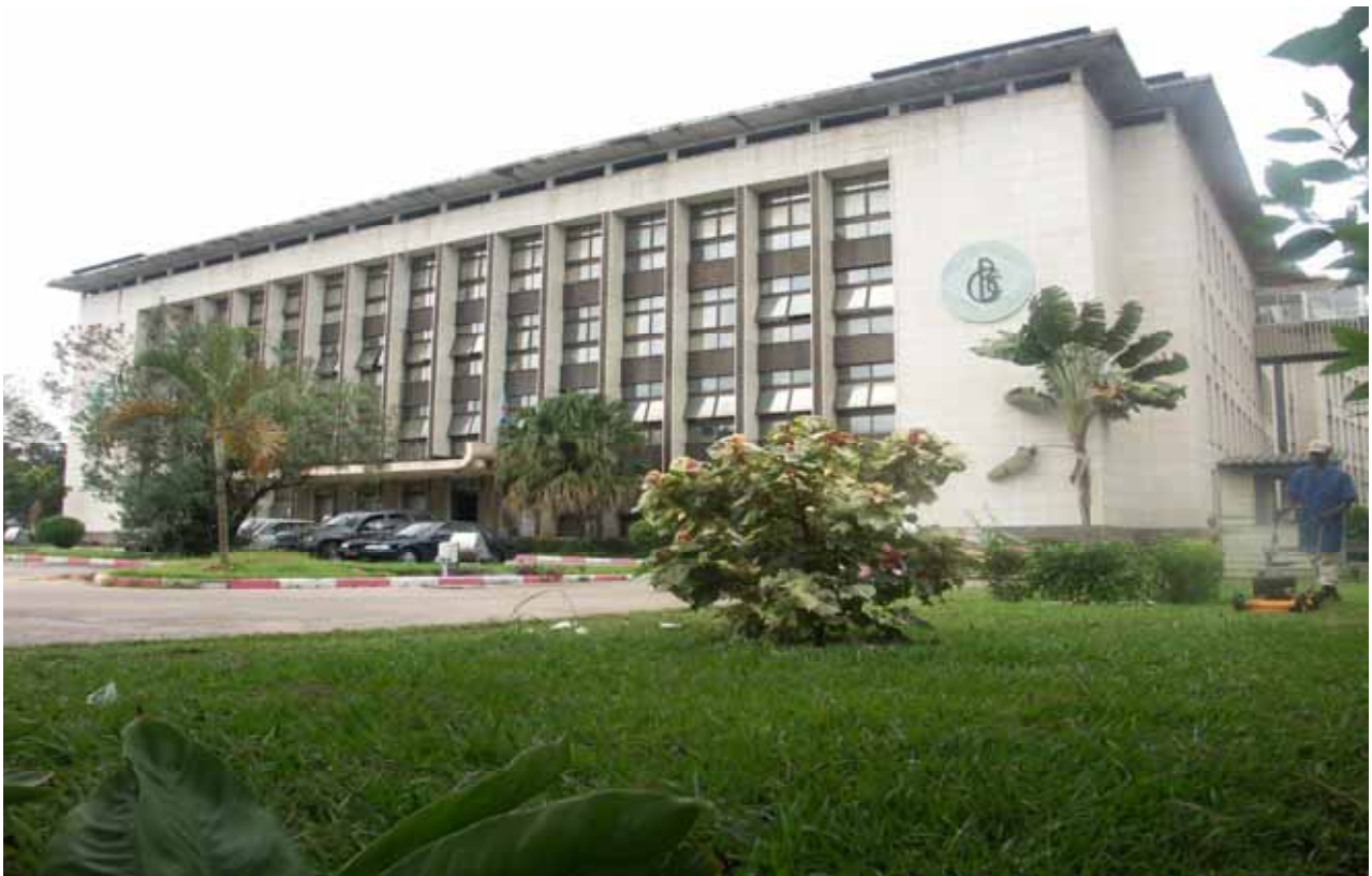
BANQUE CENTRALE DU CONGO, Siège de Kinshasa
