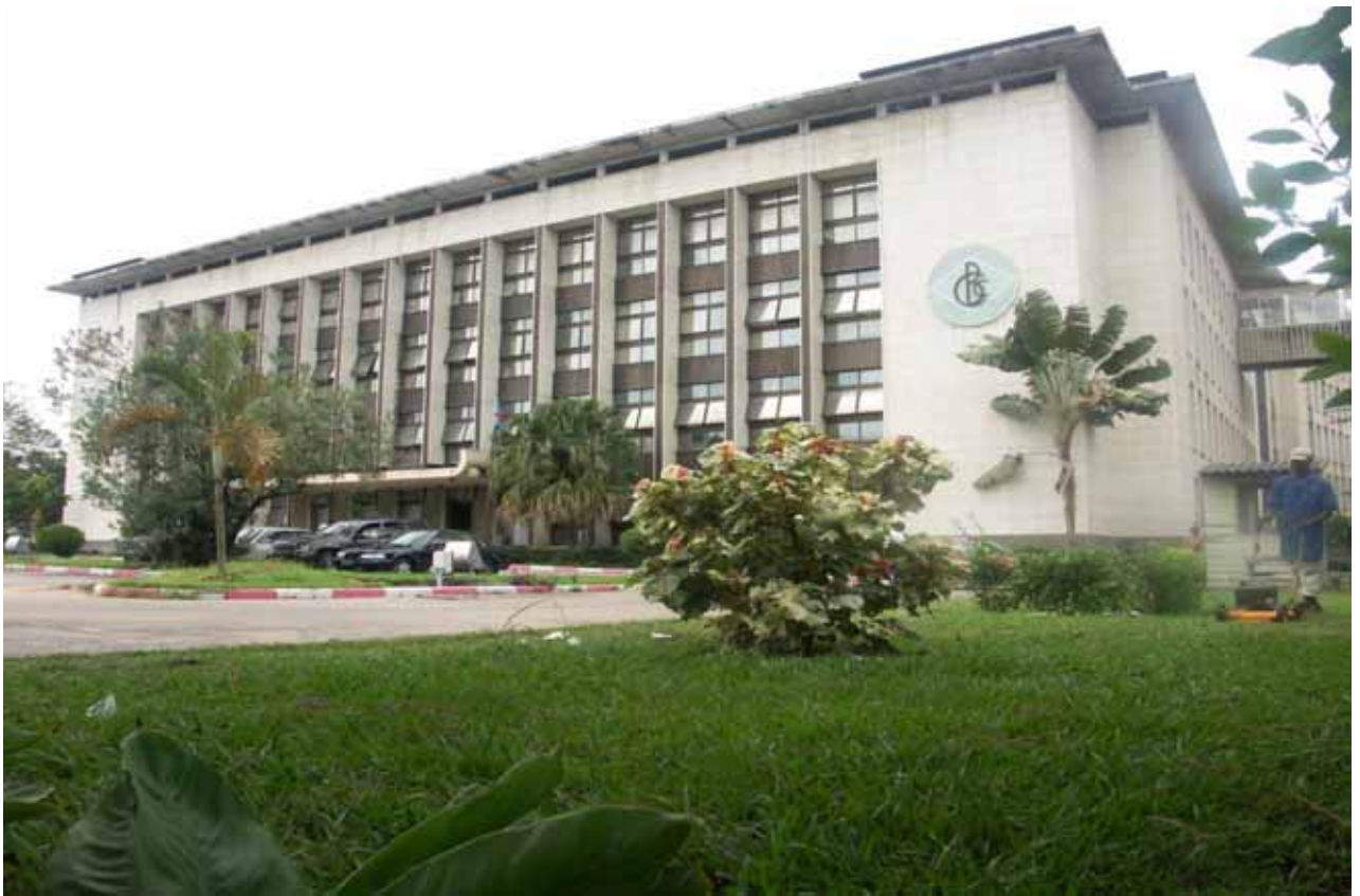
BANQUE CENTRALE DU CONGO, Siège de Kinshasa
