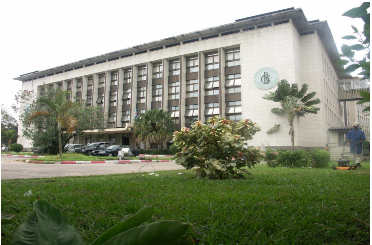
BANQUE CENTRALE DU CONGO, Siège de Kinshasa
