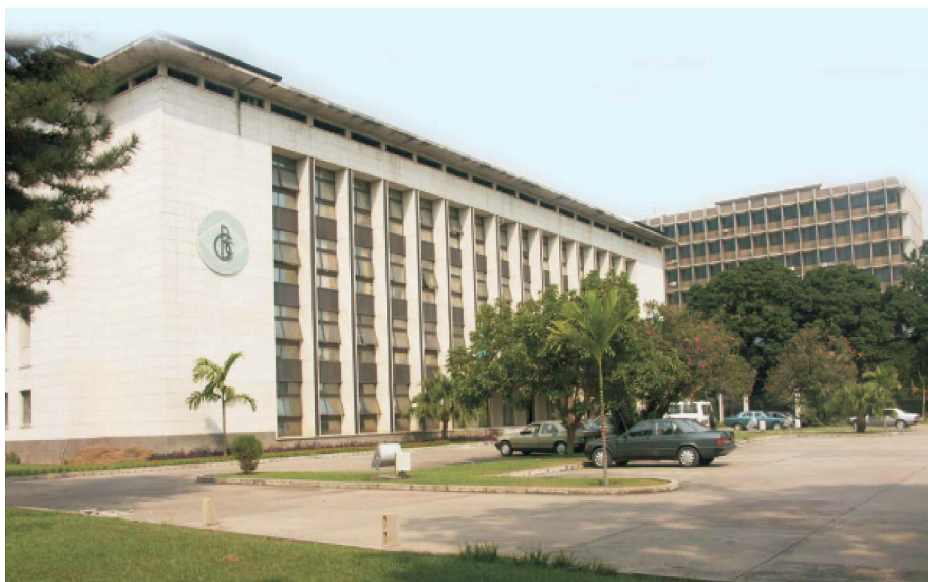
BANQUE CENTRALE DU CONGO, Siège de Kinshasa
