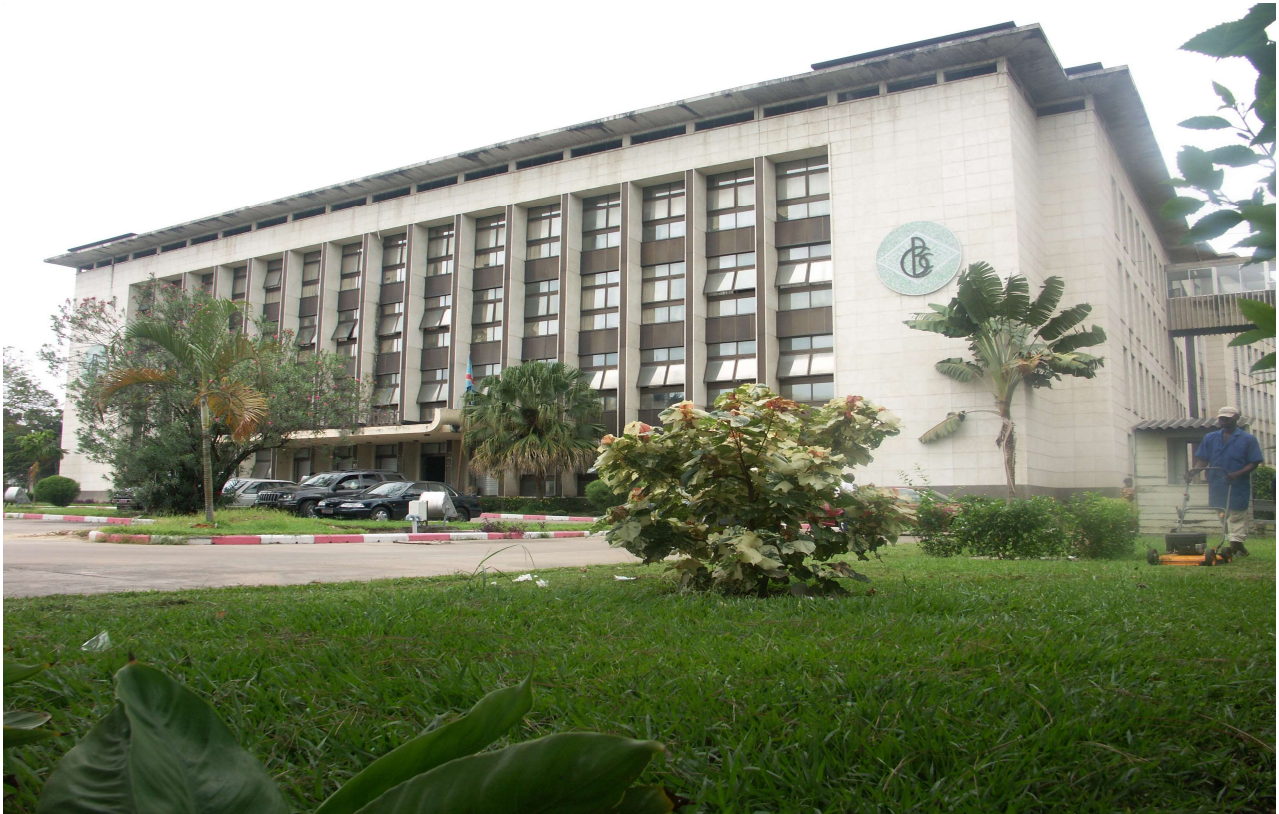
BANQUE CENTRALE DU CONGO, Siège de Kinshasa
