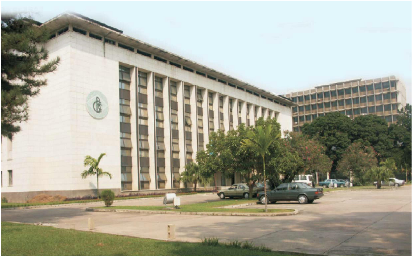
BANQUE CENTRALE DU CONGO, Siège de Kinshasa
