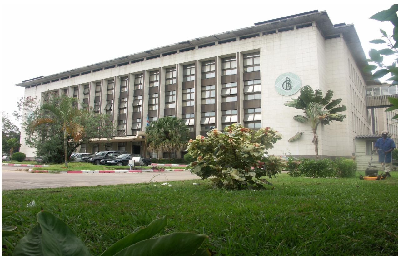
BANQUE CENTRALE DU CONGO, Siège de Kinshasa
