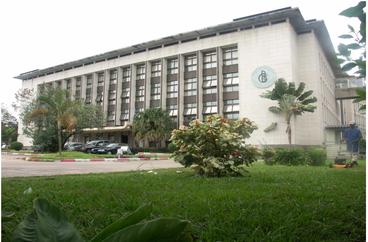
BANQUE CENTRALE DU CONGO, Siège de Kinshasa
