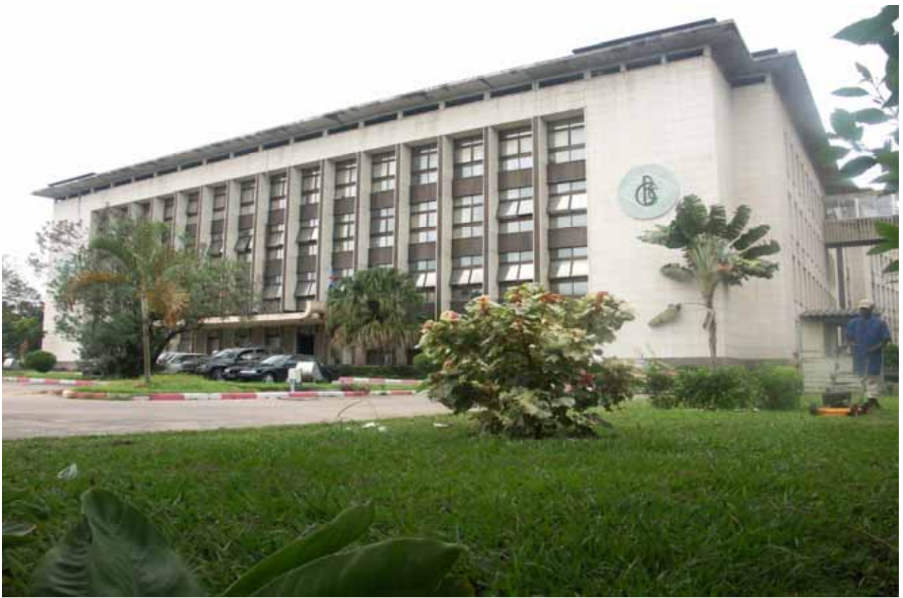
BANQUE CENTRALE DU CONGO, Siège de Kinshasa
