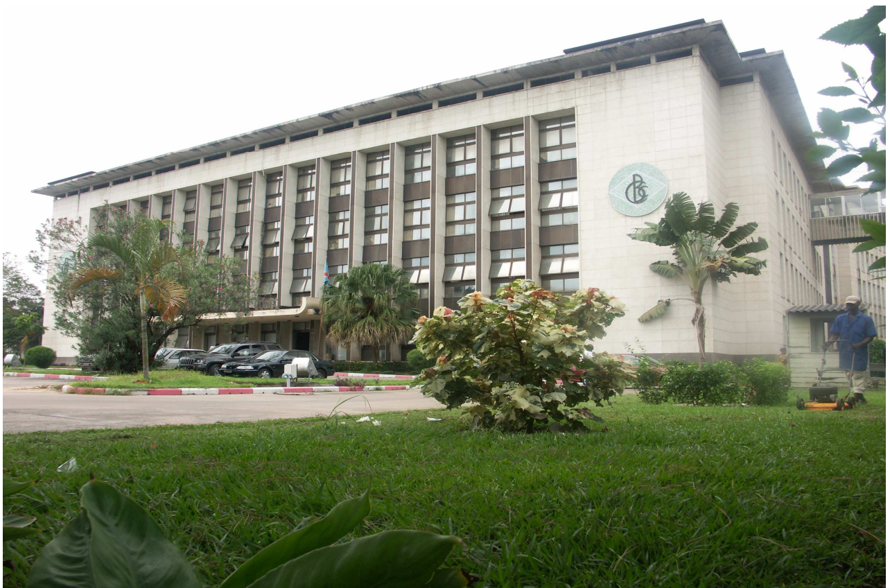
BANQUE CENTRALE DU CONGO, Siège de Kinshasa
