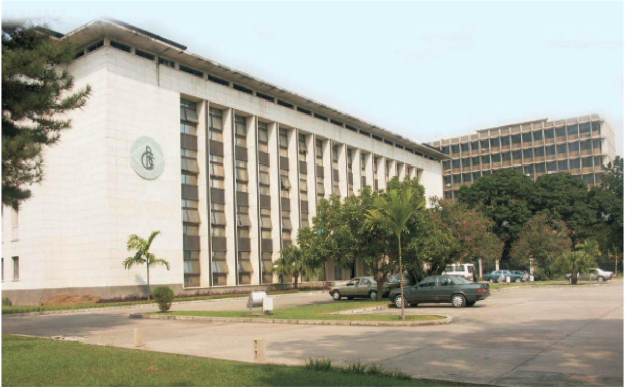
BANQUE CENTRALE DU CONGO, Siège de Kinshasa
