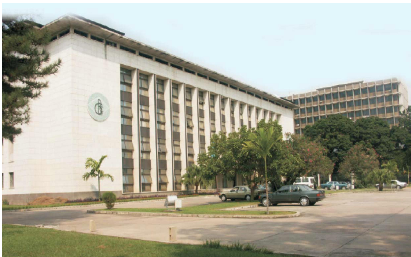
BANQUE CENTRALE DU CONGO, Siège de Kinshasa
