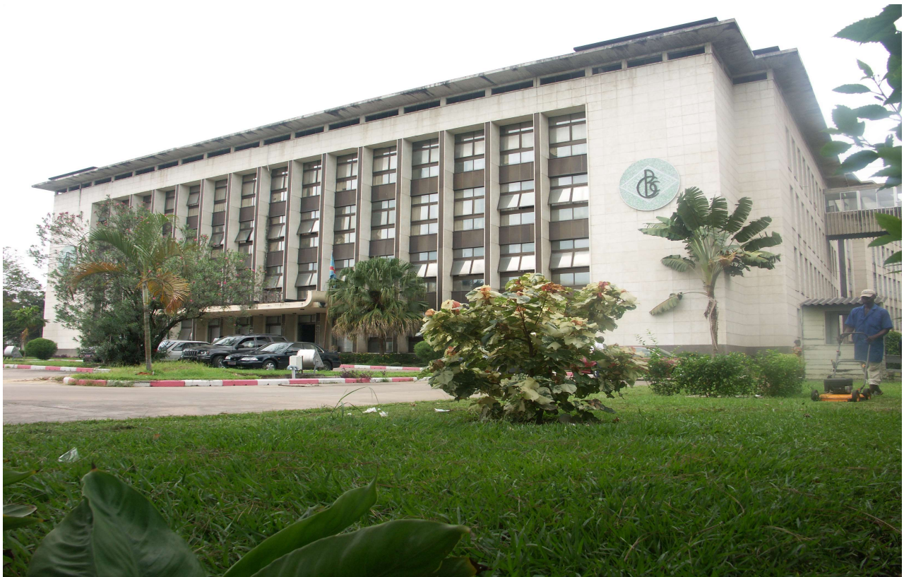
BANQUE CENTRALE DU CONGO, Siège de Kinshasa
