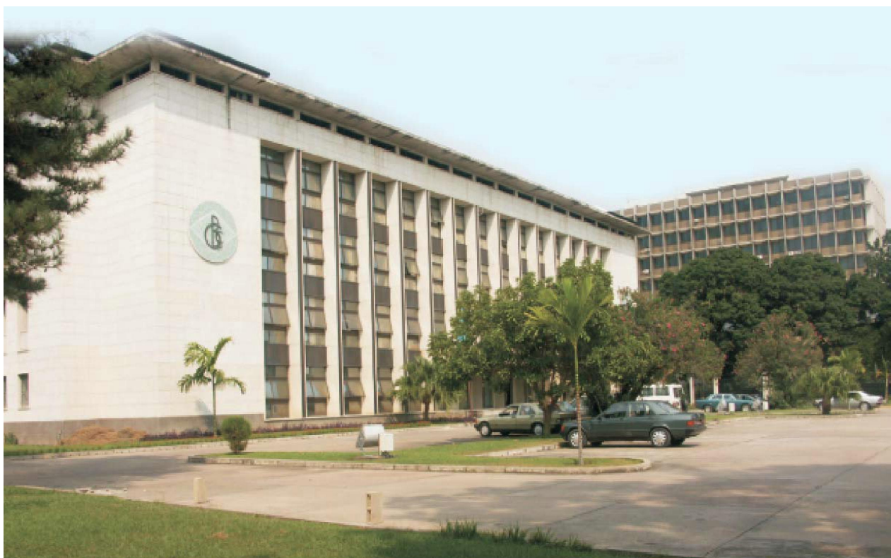
BANQUE CENTRALE DU CONGO, Siège de Kinshasa
