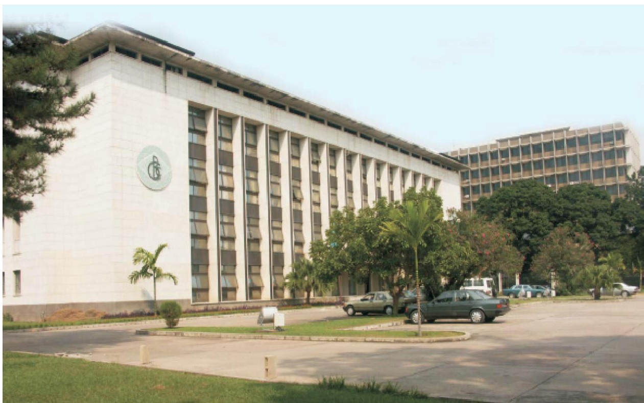
BANQUE CENTRALE DU CONGO, Siège de Kinshasa
