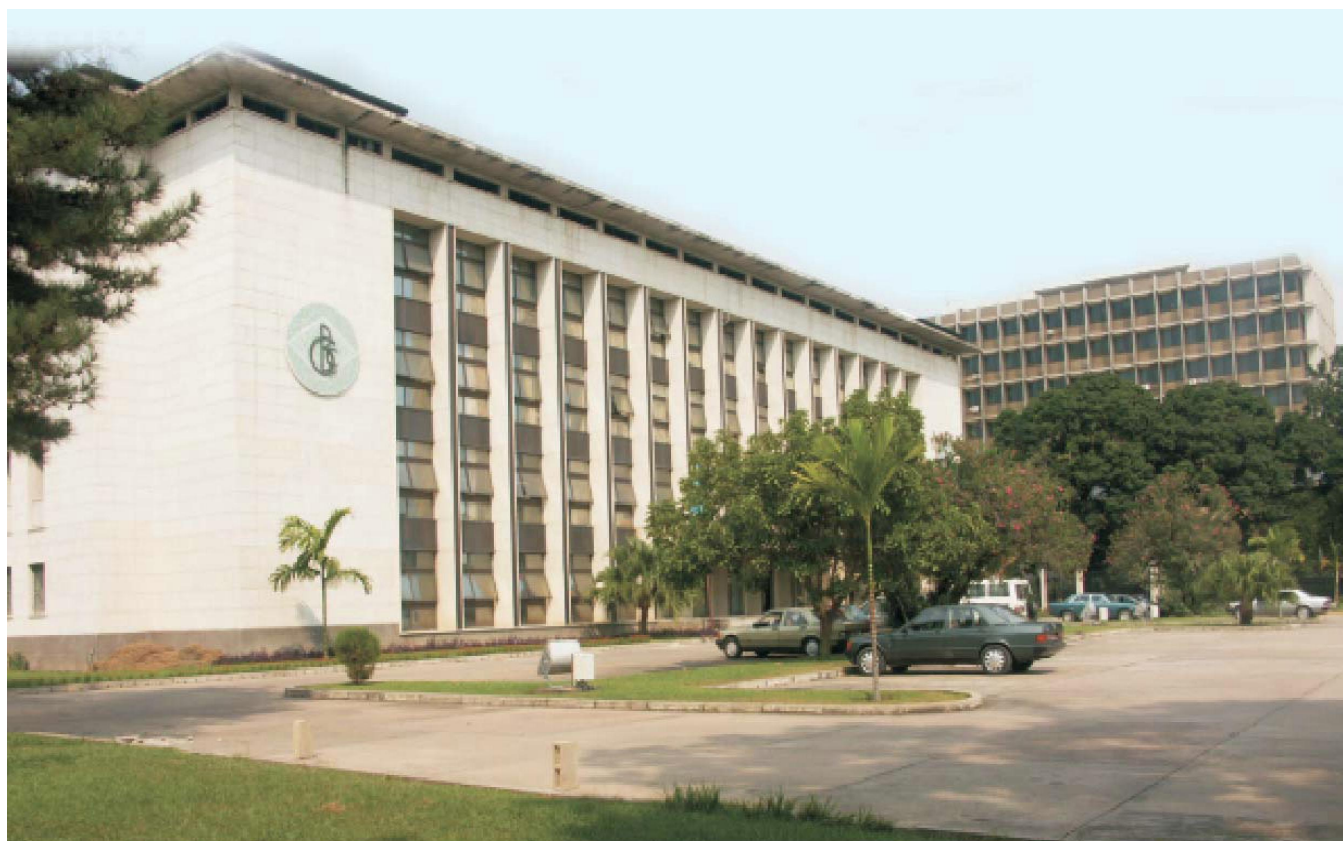
BANQUE CENTRALE DU CONGO, Siège de Kinshasa
