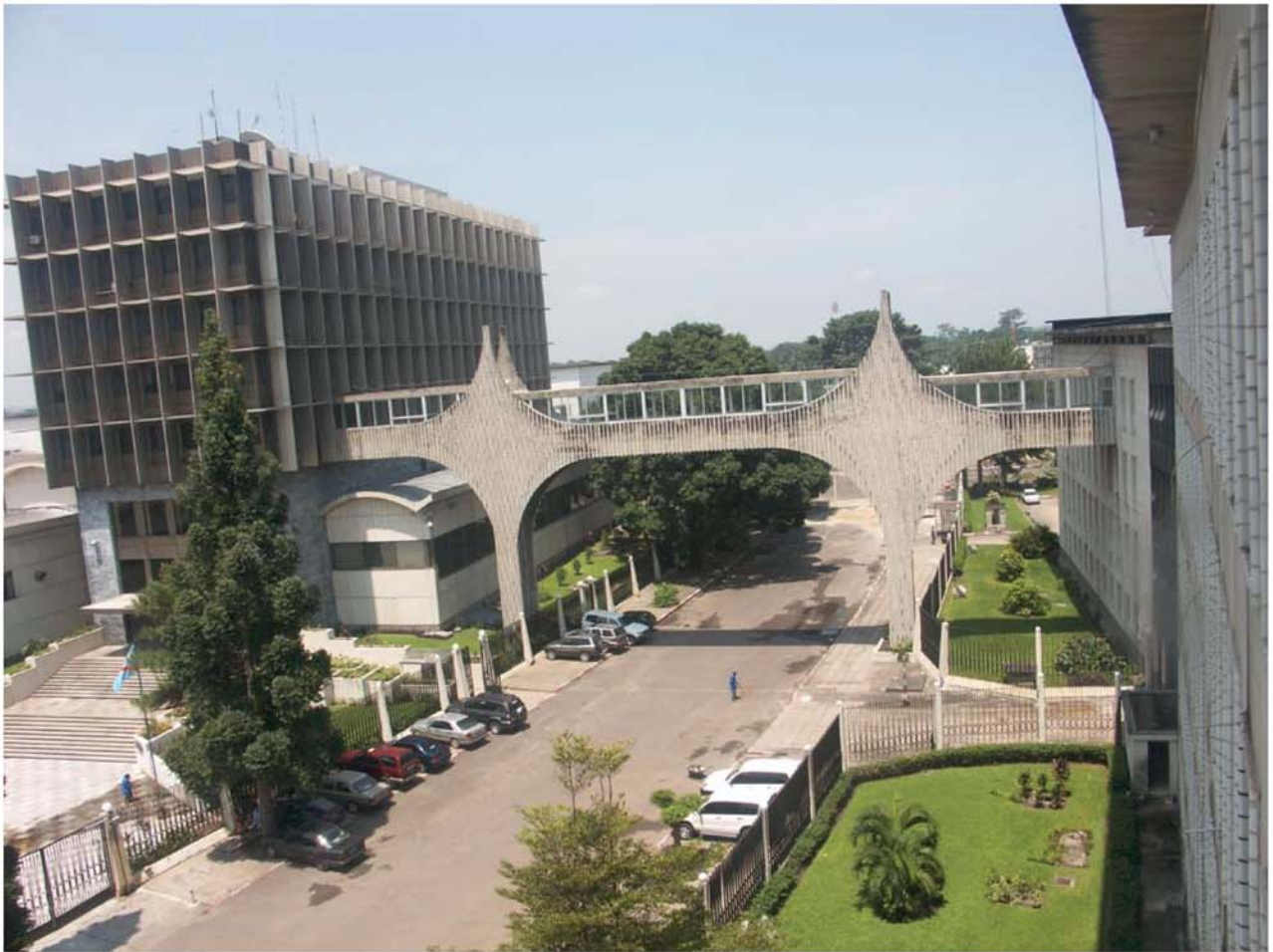
Passerelle reliant le siège de la BCC à l'Hôtel des Monnaies
